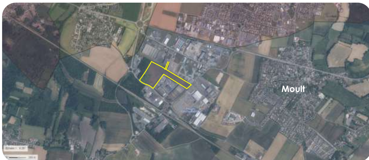
Figure 3. Vue aérienne de la zone ciblée pour la création de la ZAC de la Dolomède à Moulton-Chicheboville (14). Source : Géoportail – Atelier LD
